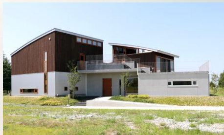
山形大学実証工房：スマート未来ハウス Yamagata University's Smart MIRAI House
